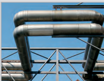
Pipeline sous pression
