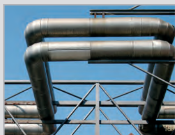
Tuberías sometidas a presión
